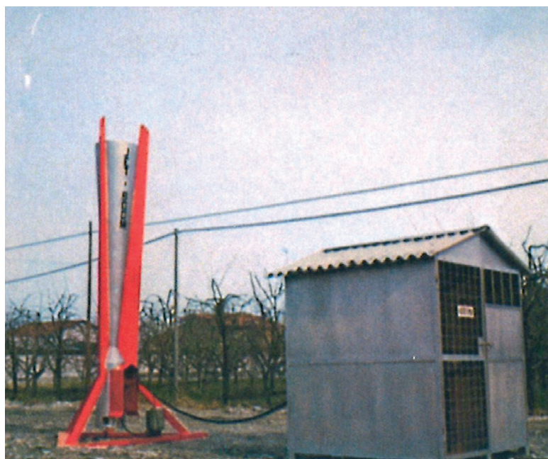
Postazione JET-BOOM con cabina prefabbricata
